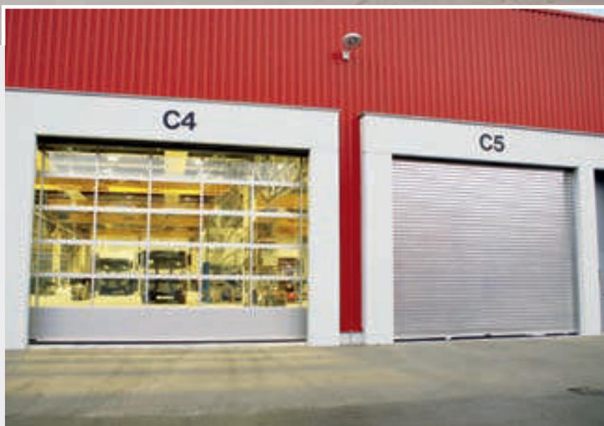
spéciale des champs) à l'intérieur du hall. Côté extérieur de la baie, une construction spéciale abrite des installations de rideaux métalliques à double paroi à une distance approximative de 500 mm des portes sectionnelles. Ces installations à double porte sont gérées par un programme de commande spécialement développé. Ainsi, toutes les portes se referment (c.-à-d. les portes sectionnelles et les rideaux métalliques ouverts) automatiquement au début de l'équipe de nuit, par exemple.
