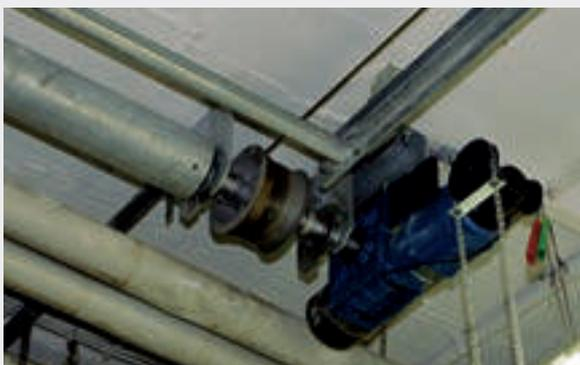
Arbre d'enroulement avec moteur électrique IP 65, axe moteur monté à l'arrière (sans ressorts de torsion)
