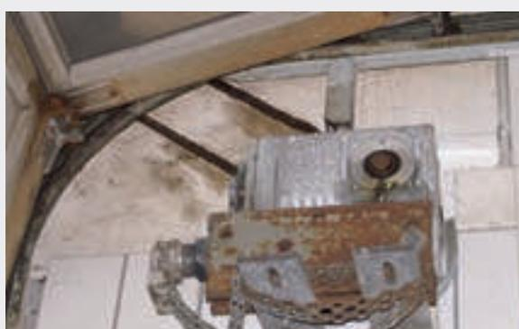
Arbre à ressort de torsion et entraînement par chaîne montés à l'avant
